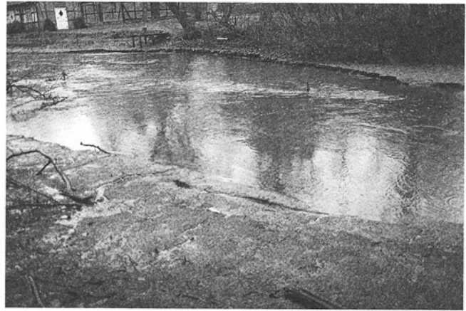
Abb. 25: Abgelassener Mühlenteich. Im Mühlenteich hatten sich staubbedingt erhebliche Sand- und Schlamm-Mengen abgesetzt. Nach Öffnung des Staus sind in der Fließrinne bereits erhebliche Sand-/Schlamm-Mengen abtransportiert worden, wie man anhand der Abbruchkanten ermaßen kann. Die dunklen Bereiche links und rechts der Fließrinne zeigen den »ursprünglichen« Teichboden: von einer Schlammschicht überdeckter Sand.
