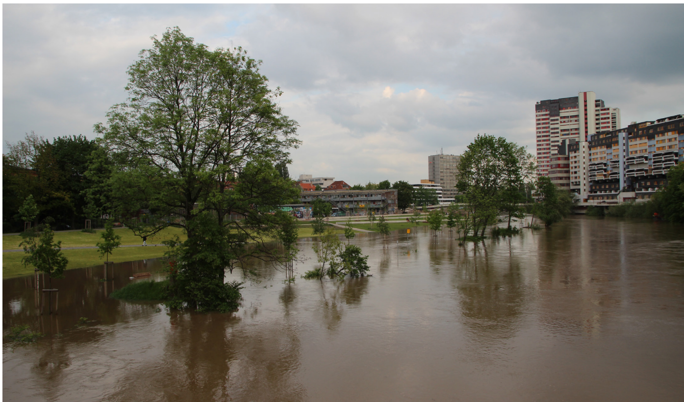
Die Querschnittsaufweitung der Ihme in Hannover im Praxistest beim Hochwasser 2013
