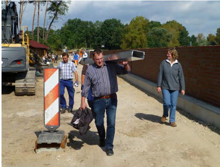
Einsetzen der Dammbalken in die mobile Hochwasserschutzwand und Sandsackbevorratung
