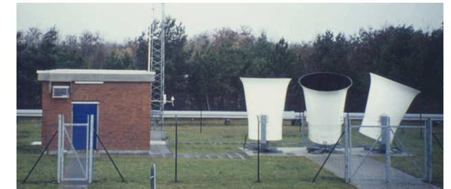
Wetterstation des Anlagenbetreibers
