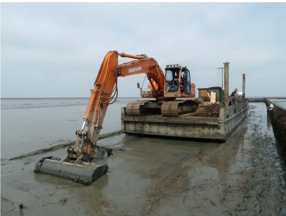
Schute mit Baggerantrieb im Lahnungsfeld
