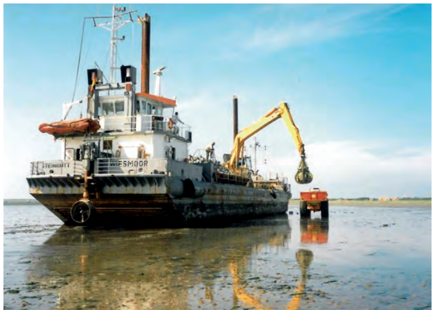
Abb. 6: Trocken gefallenes Transportschiff im Watt
