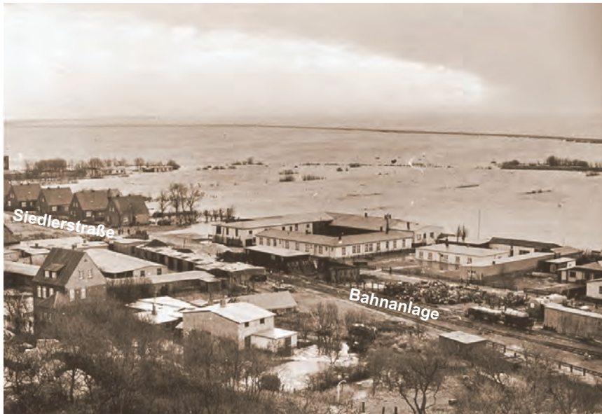
Abb. 1: Sturmflut 16./17.02.1962 - Bruch des Dorfgradendeiches
