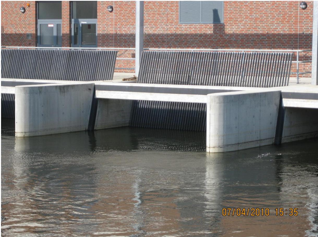
**Abbildung 5: Rechen im Einlaufbereich des Schöpfwerks**
