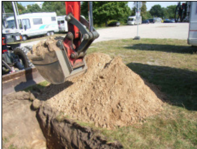
Foto 13: Schurf 17 : Schluffige Feinsand-Auffüllungen; Foto 14: Schurf 21 : Lagenweise wechselnde Sandauffüll.
