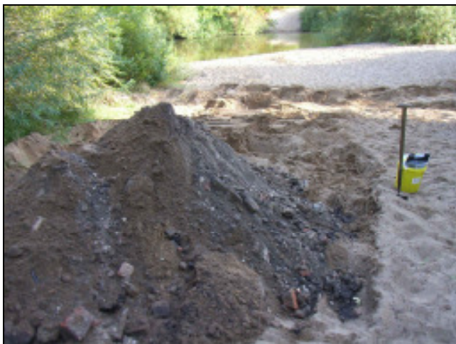
Foto 3: Schurf 3 mit Allersand-Überdeckung;
