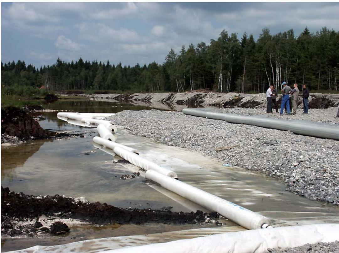
**Bild 5.7.1-2:** Aufbau der Tragschicht mit Geogittern BAB A7 bei Füßen
