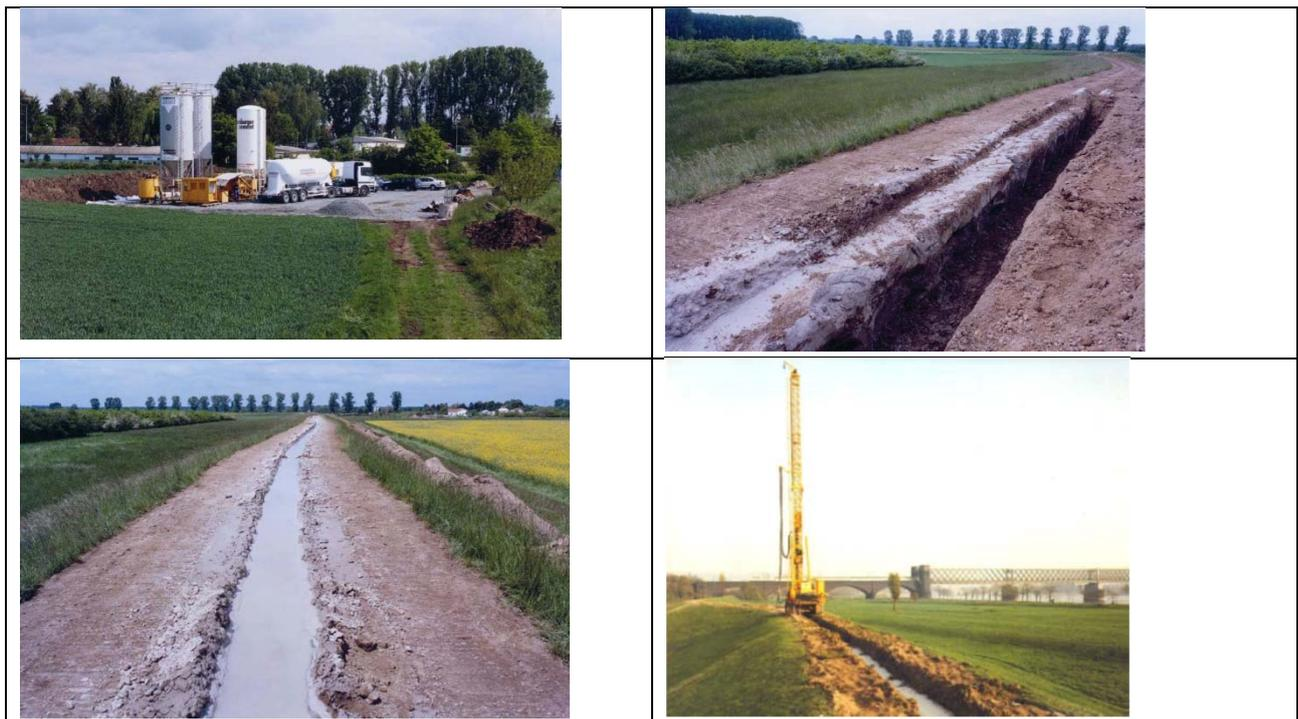
**Abbildung 5.2.1-1:** Rüttelschmalwand
