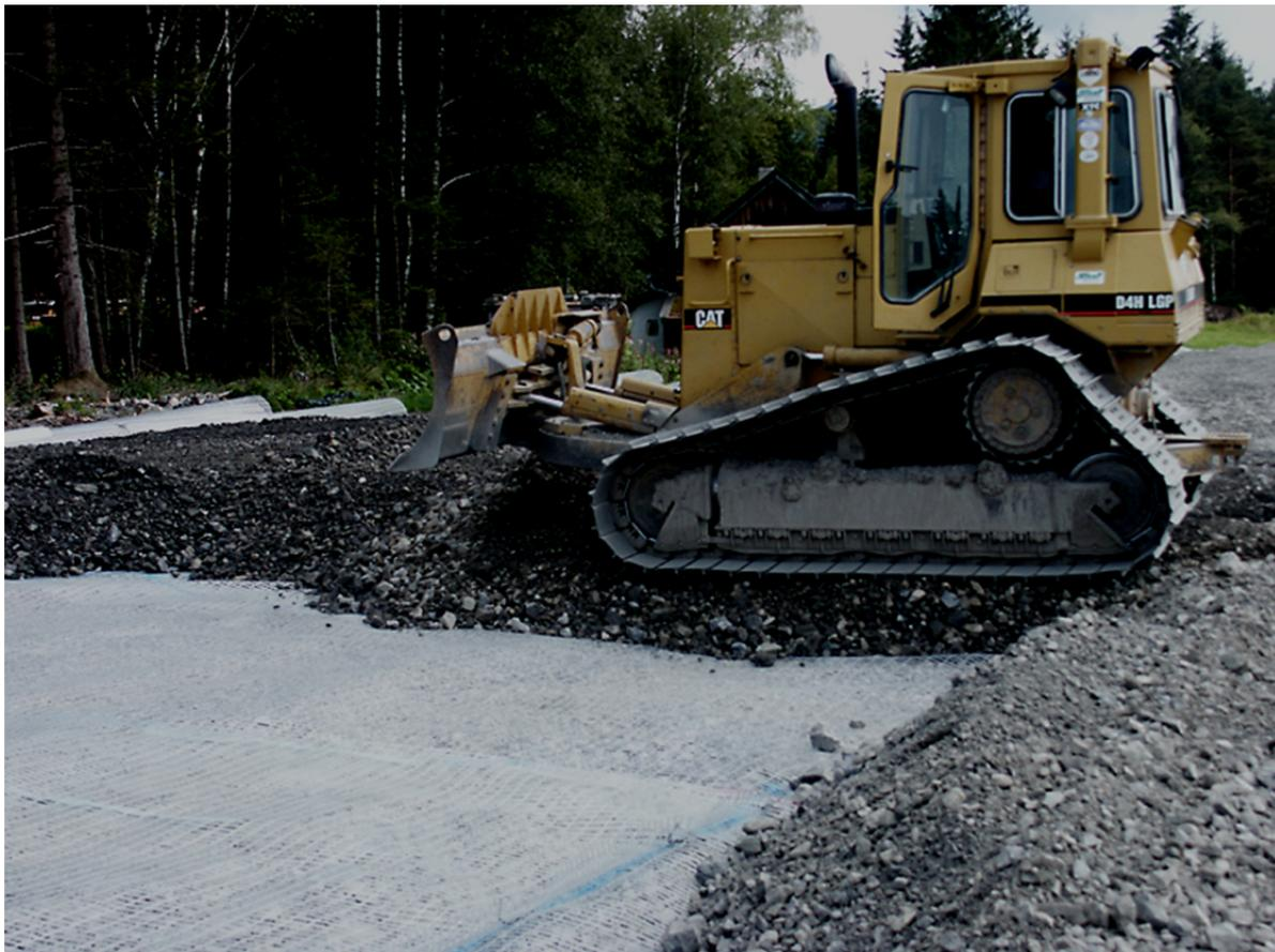
**Bild 5.7.1-3:** Tragfähigkeit der Tragschicht mit Geogittern BAB A7 bei Füßen
