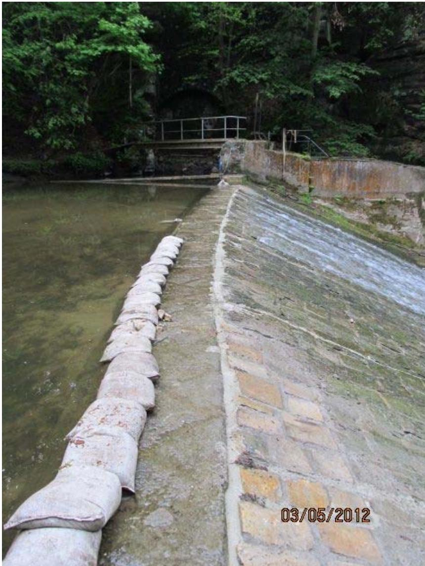
**Bild 3.2.2-1:** Sedimente im Bereich der Wehrkrone
