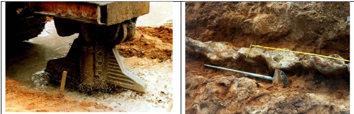
**Abbildung 5.2.1-3:** Flügelrüttler vor dem Eintauchen in den Boden, Freigelegter Kopf der Schmalwand
