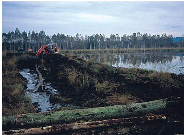
**Bild 5:** Der Enddamm des Egelseegrabens wurde nach unerwarteter starker Torfsetzung in der Dammschüttung nachträglich verstärkt. (Hinter dem Bagger die für den Torftransport benötigte Moorraupe)
