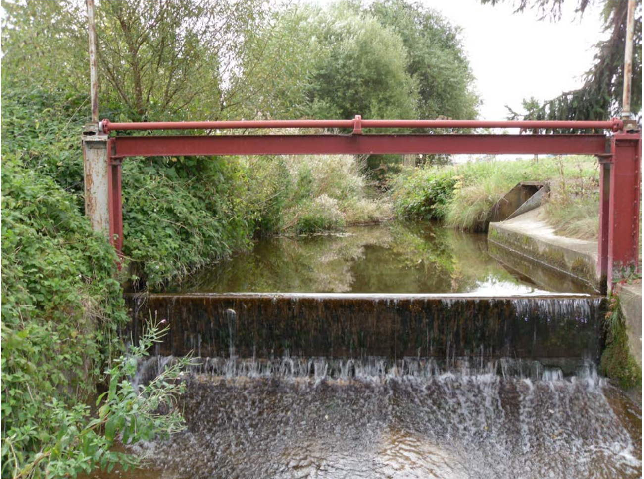
Staubauwerk Gronau an der Despe Quelle: Knut Köster, NLWKN Hildesheim
