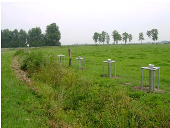
Abb. 1: Grundwasser-Messstellengruppe R 82 Wirdum I-IV.
