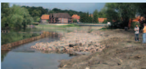
Sohlgleite in Bau
