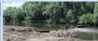
Sohlgleite in Bau - Blick flussaufwärts
