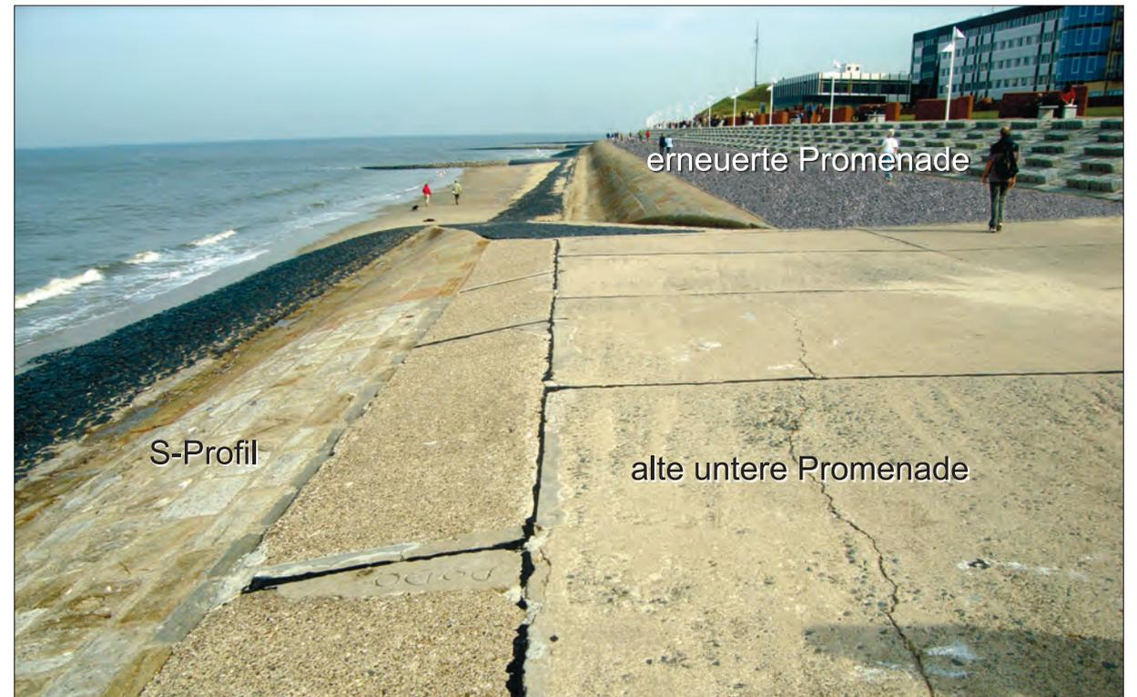
Abb. 2: Schadhafte Betonplatten der unteren Promenade
