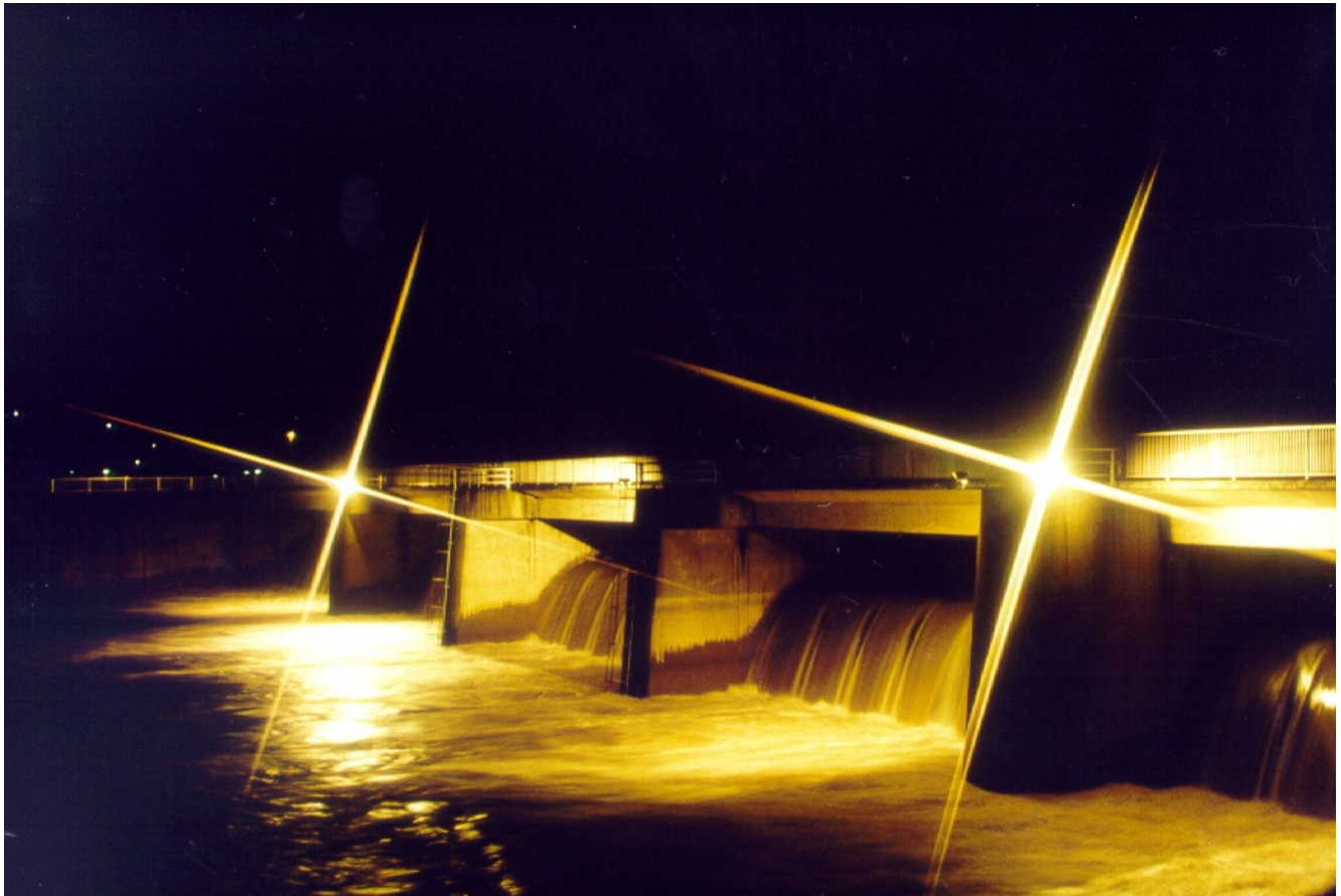
Abschlussbauwerk Salzderhelden, Staubetrieb bei Nacht Quelle: unbekannt
