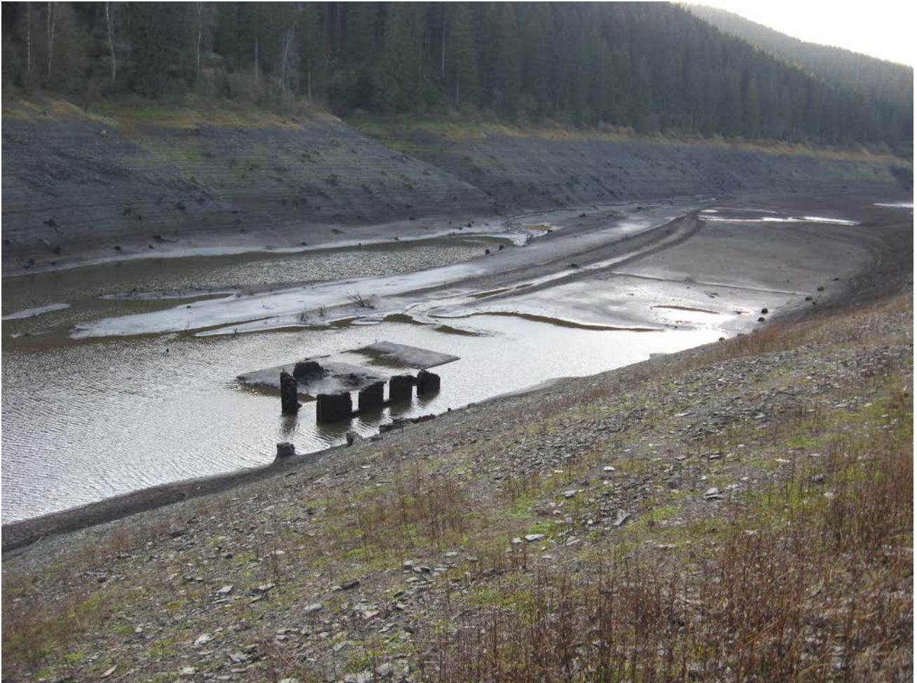
Okertalsperre bei Trockenwetter Quelle: Harzwasserwerke Hildesheim
