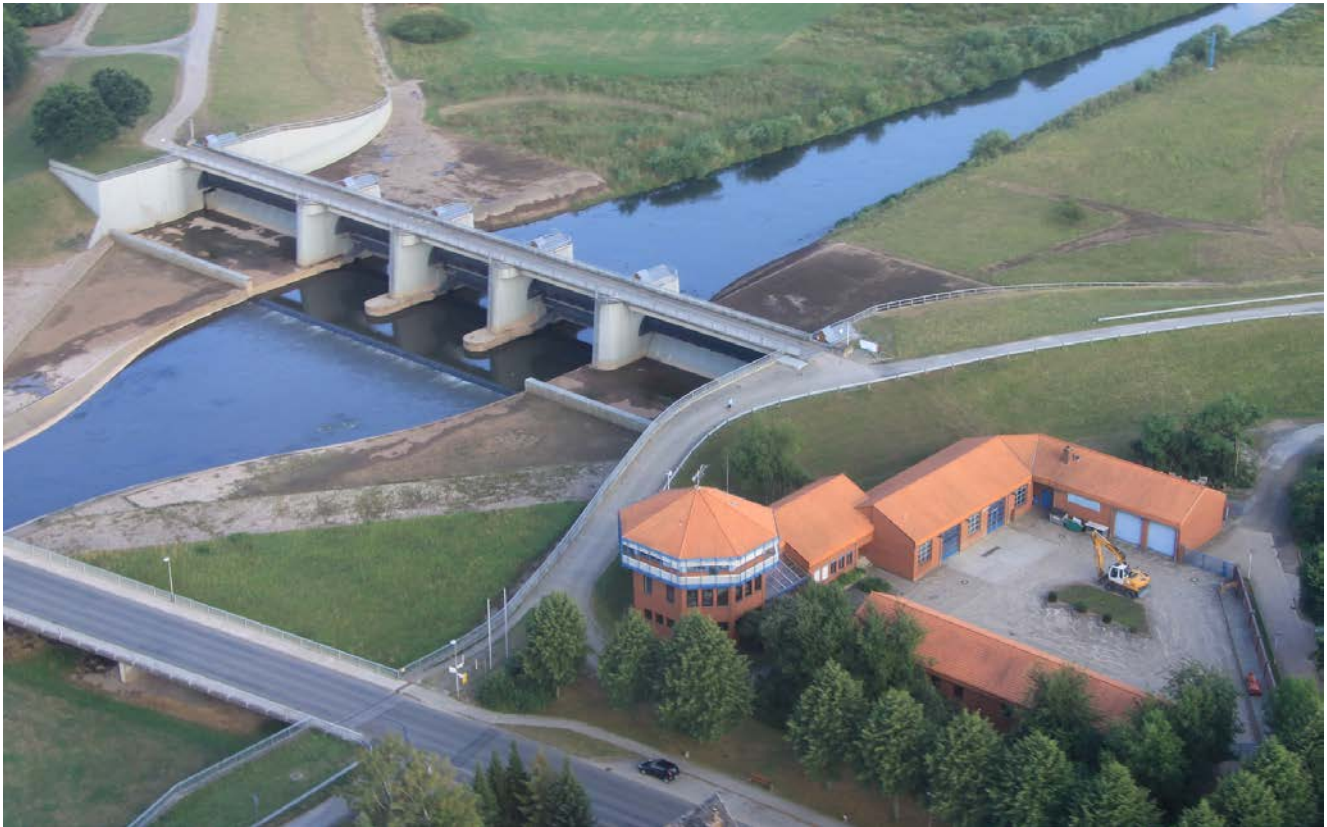
Abschlussbauwerk Salderhelden und Betriebshof mit Steuerzentrale
