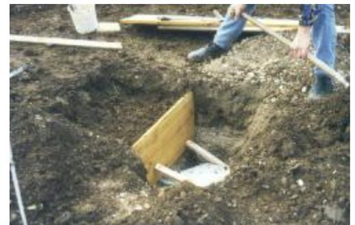
Abb. 4: Wiederauffüllen des Bodenaushubs. Zu erkennen ist die seitliche Holzabstützung zur Kanistergrube.
