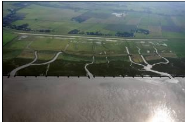
Abb. 5 - 19 Kompensationsmaßnahme Wurster Küste (bremenports)
