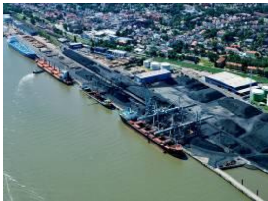
Abb. 5 - 6 Hafen Nordenham (Niedersachsen Ports)
