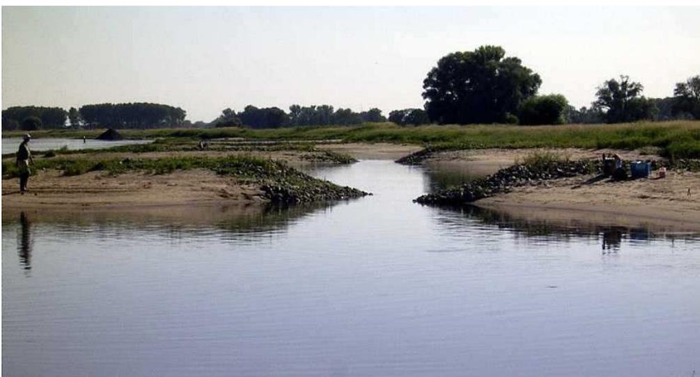
**Abbildung 121:** Kerbbuhnen an der Elbe (BFG 2009)
