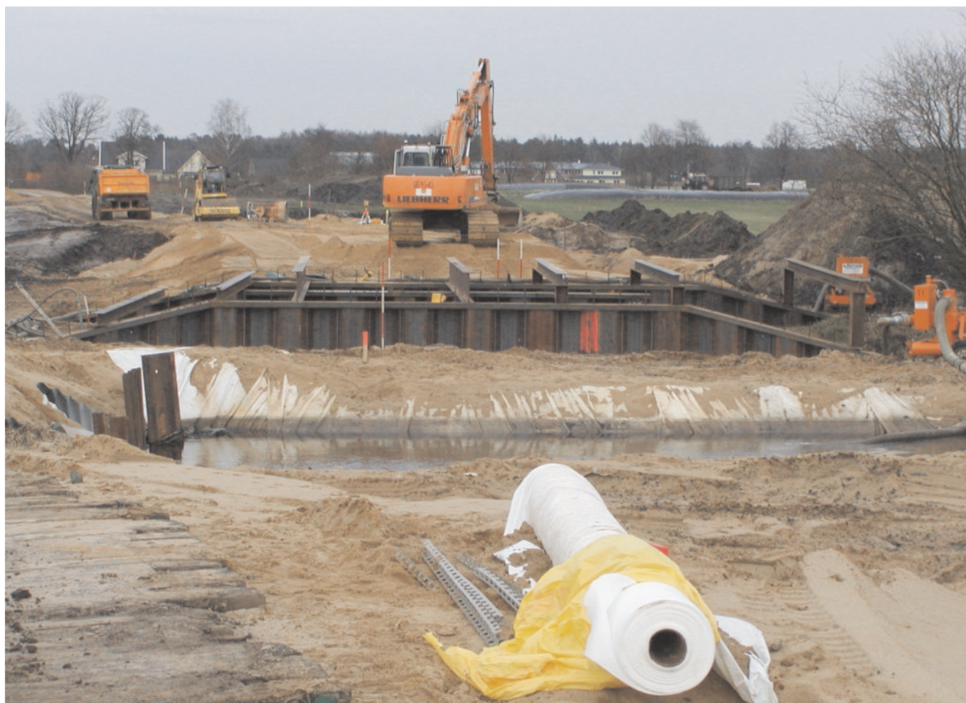
Hochwasserschutzdamm der Gemeinde Lauenbrück im Bau: Niedersachsen investiert 2011 mehr als 20 Millionen Euro in den Hochwasserschutz.
