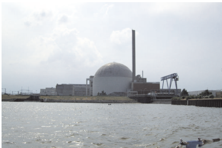
Das Kernkraftwerk Stade wird zurück gebaut.
