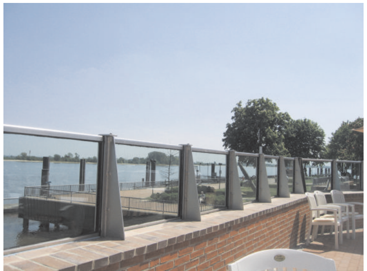
Ein Pilotprojekt: Glaswände als Flutmauer in Brake.
