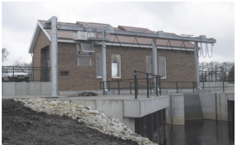
Dank der Zuschüsse aus Brüssel konnte das Schöpfwerk Wagnerfehn schneller gebaut werden.
