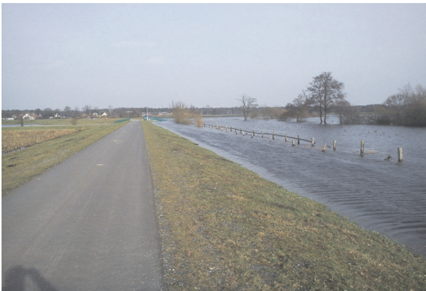
Hochwasser in der Fintau – jetzt gibt es einen wirksamen Schutz.
