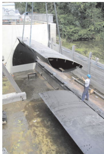
Wehranlage Blütlingen: Die sanierte Fischbauchklappe wird eingesetzt!
