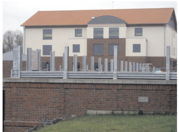
Die Hochwasserschutzwand und das Schöpfwerk in Hitzacker haben sich bewährt; ebenso wie unsere professionelle Arbeit.
