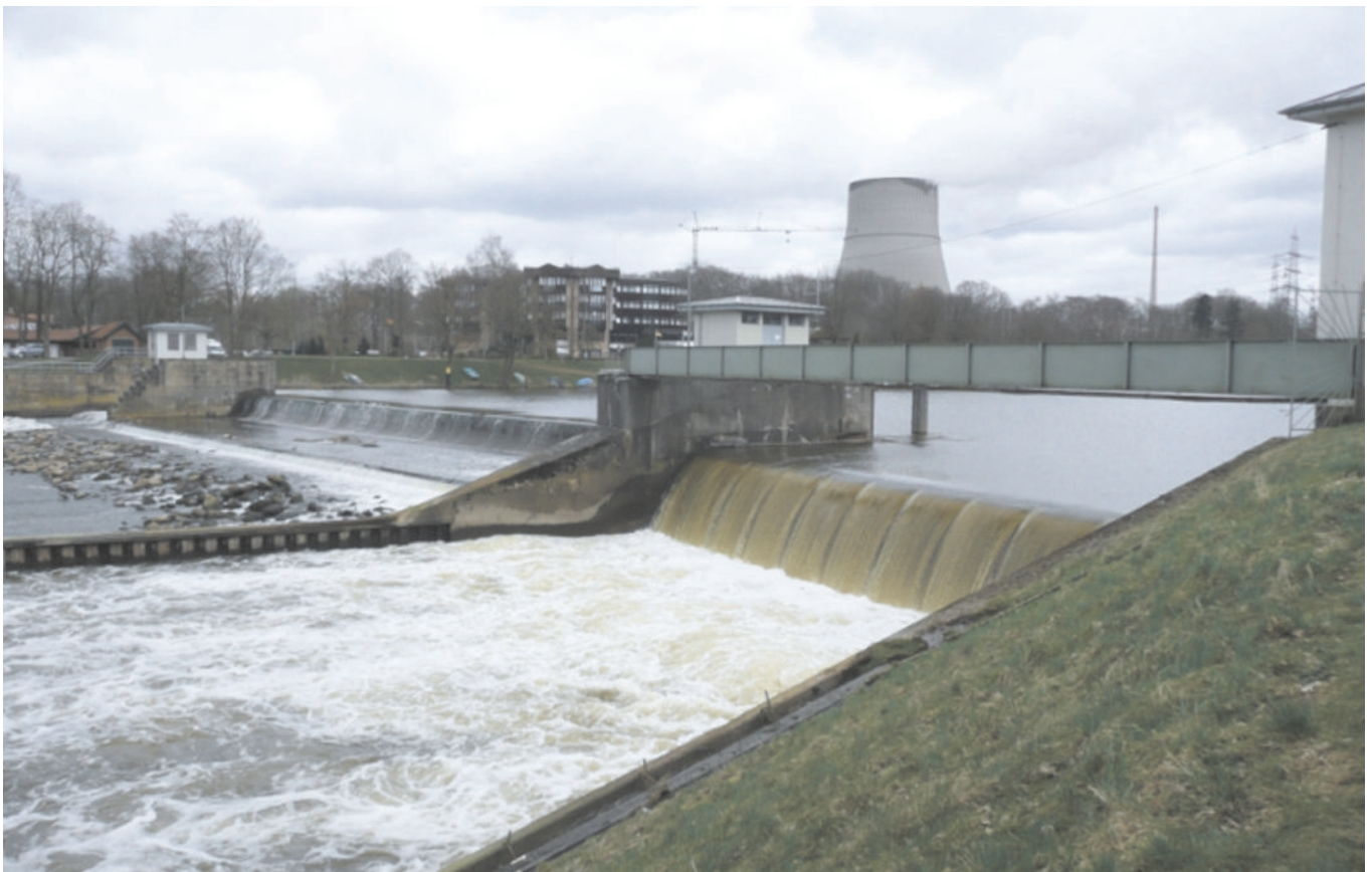
Das Emswehr Hanekenfähr: Soll hier eine Wasserkraftanlage gebaut werden?
