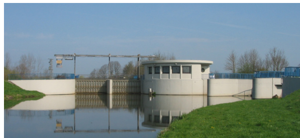
Verteilerbauwerk Hochwasserrückhaltebecken Alfhausen-Rieste
