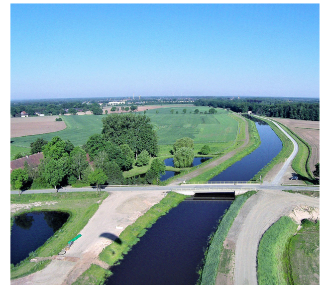
Dämme an der gehobenen Hase
