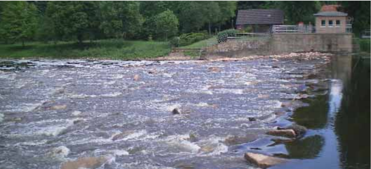
Raue Rampe nach der Fertigstellung.
