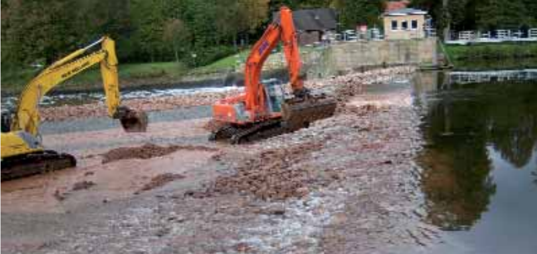
Bauarbeiten am Wehr.
