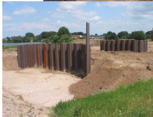
Stahl-Spundwände für Brückenwiderlager Juni 2009
