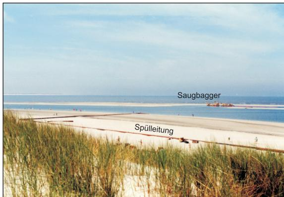
Abb. 4: Sandentnahme mit Spülleitung
