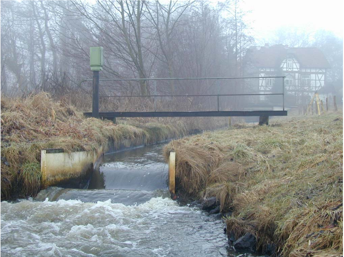
Pegel Köhlener Mühlbach - Blick über das Venturigerinne nach oberhalb auf den Messsteg Quelle: NLWKN Lüneburg
