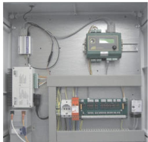
Pegel mit Datensammlern und Datenfernübertragung in Kompakt- und Modulbauweise
