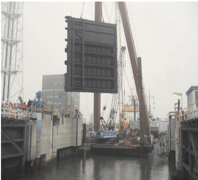
Einbau der Tore im Sperrwerk „Schleusenpriel“ in Cuxhaven
