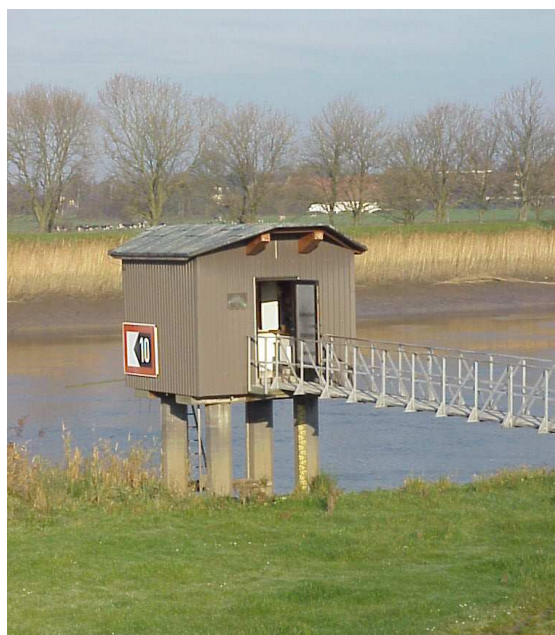
Abb. 9: Gewässergütemessstation mit Durchfluss – Ultraschallmessanlage Leer
