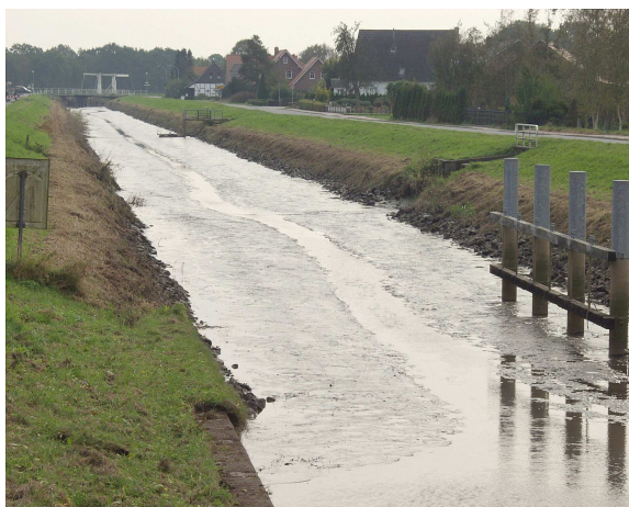
Abb. 8: Nordgeorgsfehnkanal im Bereich der Schleuse 1; Blick nach Süd, rechts ist die Ortschaft Brückenfehn zu erkennen
