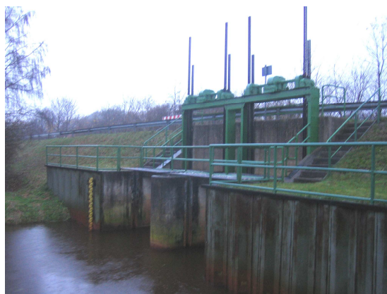
Abb. 14: Einlauf zum Dücker der Soeste unter den Küstenkanal
