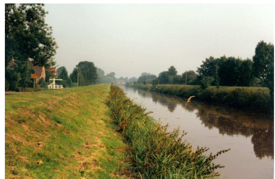
Abb. 19: Deich entlang des Hauptfehnkanals zwischen der Einmündung des Burlage-Langholter Tiefs und der „Tobias-Brücke“
