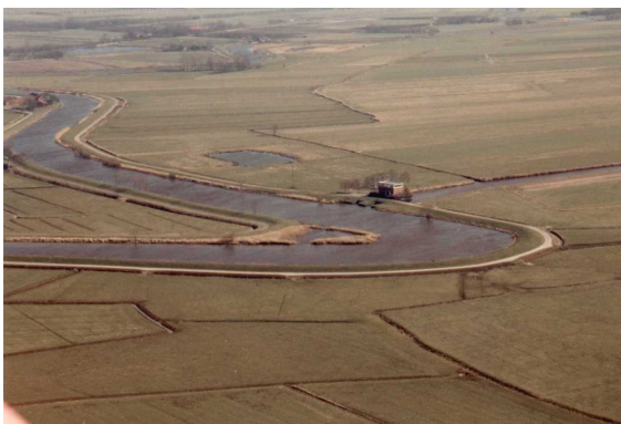
Abb. 27: Luftaufnahme mit Blick über das Holter Schöpfwerk nach Südost über Teile des Holter Hammrichs.
