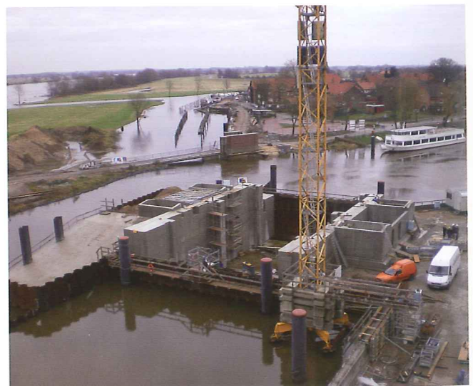
Sielbauwerk im Dezember 2007
