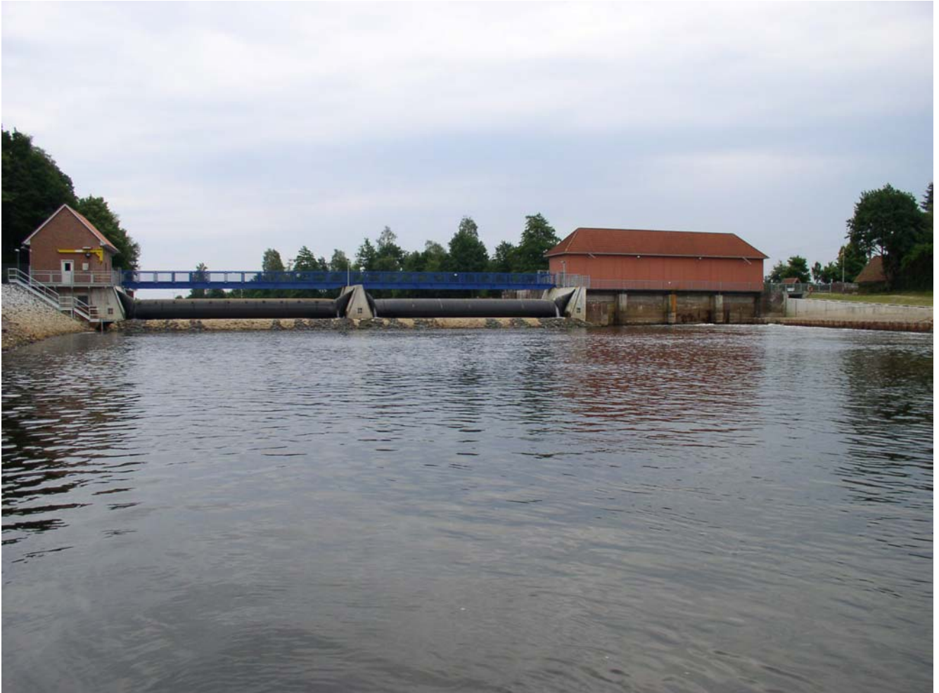
Schlauchwehr Marklendorf/ Aller Juni 2008 Quelle: NLWKN
