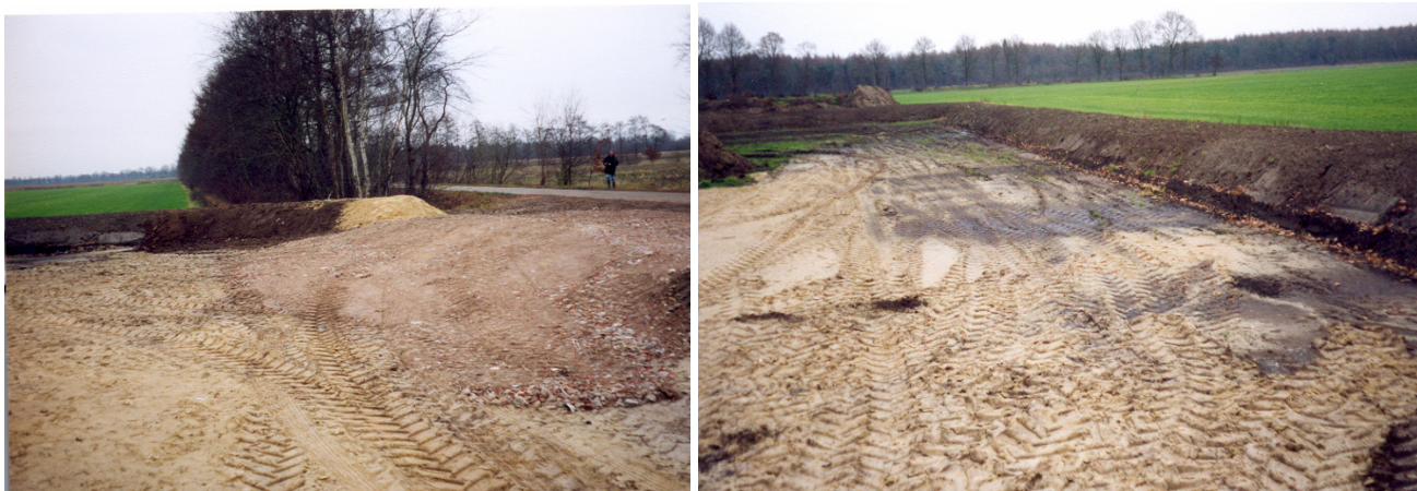
Abb. 12: Umwallung einer Biogasanlage in der Fertigung
