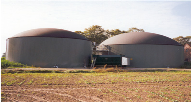
Abb. 5: Fermenter und Lagerbehälter
