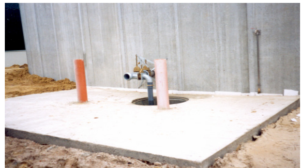
Abb. 6: Befestigter Abgabebereich mit Auffangbehälter
