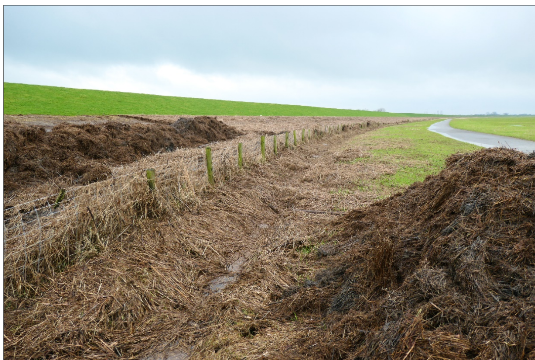
Abb. 3: Außenseitiger Deichfußgraben vor der Aufreinigung
