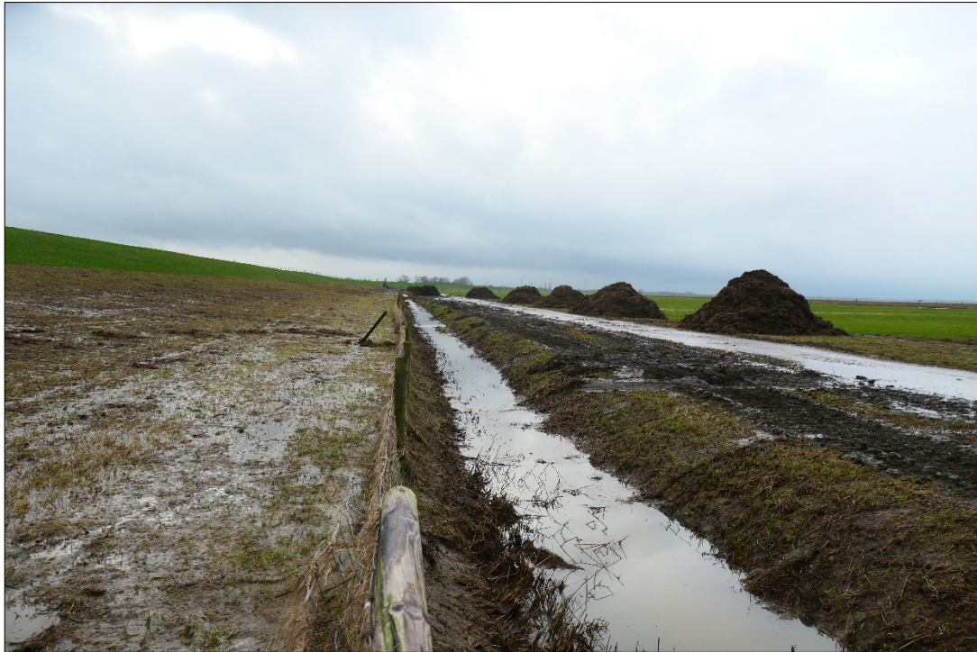
Abb. 4: Außenseitiger Deichfußgraben nach der Aufreinigung
