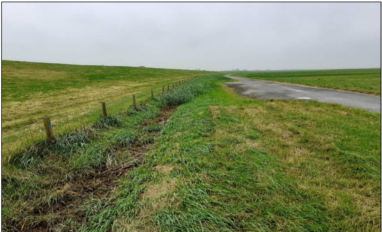
Abb. 5: trockener Bereich Deichfußgraben, Blick nach Westen
