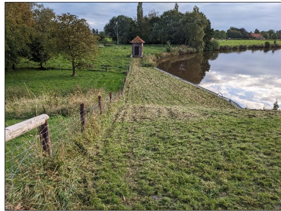
Abb. 3: Pumpenhäuschen an der Jade
