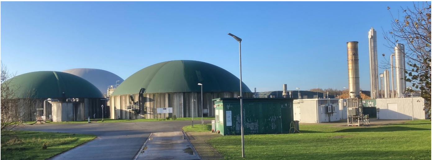
Abb. 35: Biogasanlage mit Nutzung nachwachsender Rohstoffe.
