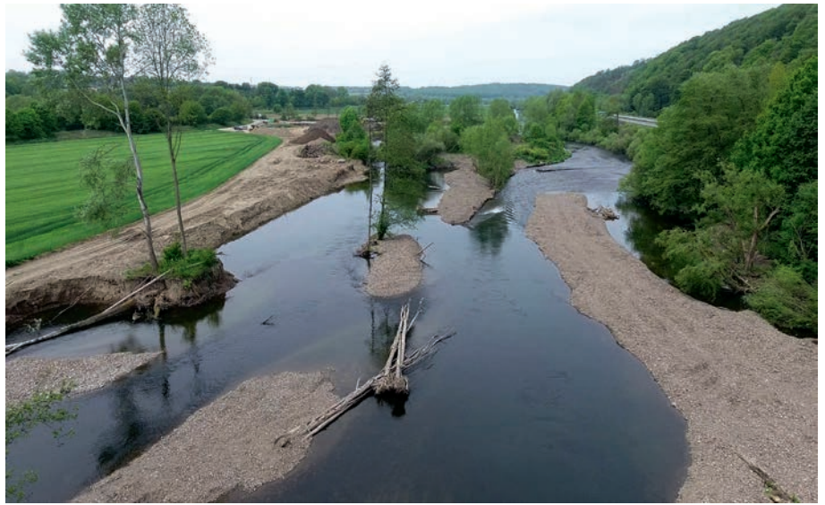
Abb. 3: Leitbildtypische Strukturentwicklung und Anlage einer Sekundäraue an dem Mittelgebirgsfluss Ruhr bei Arnsberg (Vortrag Schackers, Foto: Bezirksregierung Arnsberg/H. Kulik)
