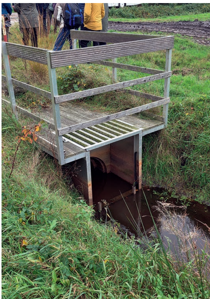
Abb. 5: Einfache, aber durchdachte Konstruktion zur Anhebung des Moorwasserstandes und Anreicherung des oberen Grundwasserleiters: Stauanlage aus seewasserfestem Aluminium, passgenau in einen Durchlass gesetzt und manuell bedienbar. (Vortrag Matheja, Foto: L. Heidberg)
