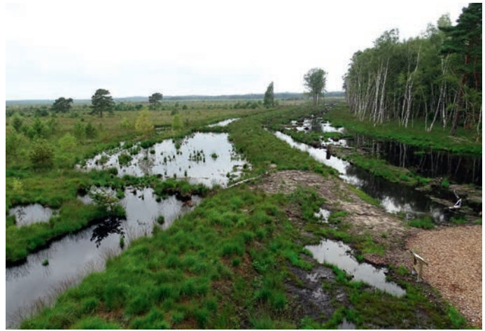
Zur Wasserhaltung gebaute Moordämme müssen langfristig kontrolliert werden. (Foto: J. Fahning)
