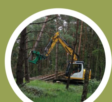
Lebende Hochmoorflächen sind wassergesättigt und größtenteils waldfrei. Um diesen Zustand zu erreichen, muss das Regenwasser in den Moorflächen zurückgehalten werden. Dafür muss zunächst aufwachsendes Gehölz auf den geplanten Dammtrassen moorschonend entfernt werden. Anschließend werden Moordämme aus gebietseigenem Torf gebaut und bestehende Entwässerungsgräben verschlossen.
