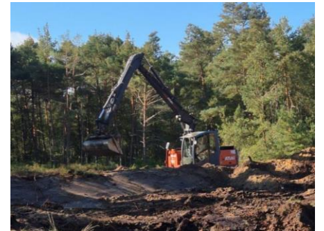
Erdbauarbeiten; Foto: J. Franz
