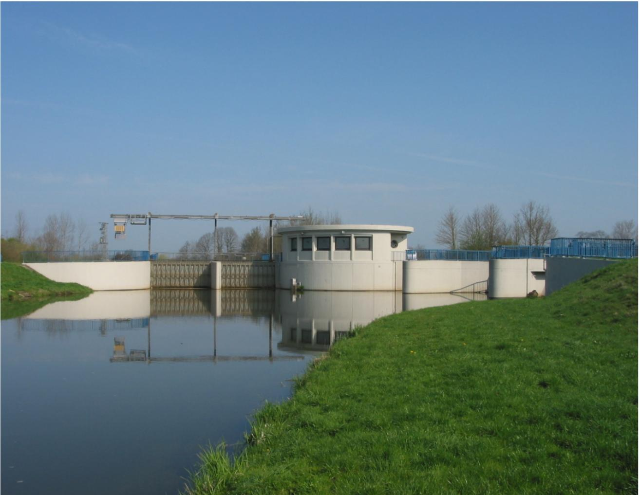
Verteilerbauwerk für das Hochwasserrückhaltebecken Alfhausen-Rieste Quelle: NLWKN Cloppenburg
