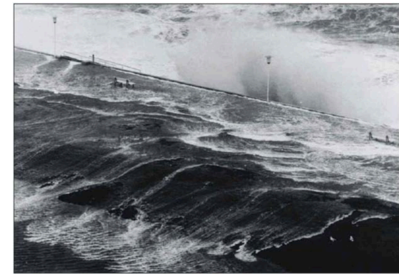
Abb. 4: Durch wellenüberlauf am Deckwerk an der Kaiserwiese während der Sturmflut vom 03.01.1976 fließen erhebliche Mengen Wasser in die Stadt Norderney
