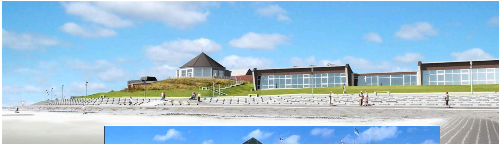
Abb. 1: Panorama des neuen Deckwerkes vom Strand aus gesehen
