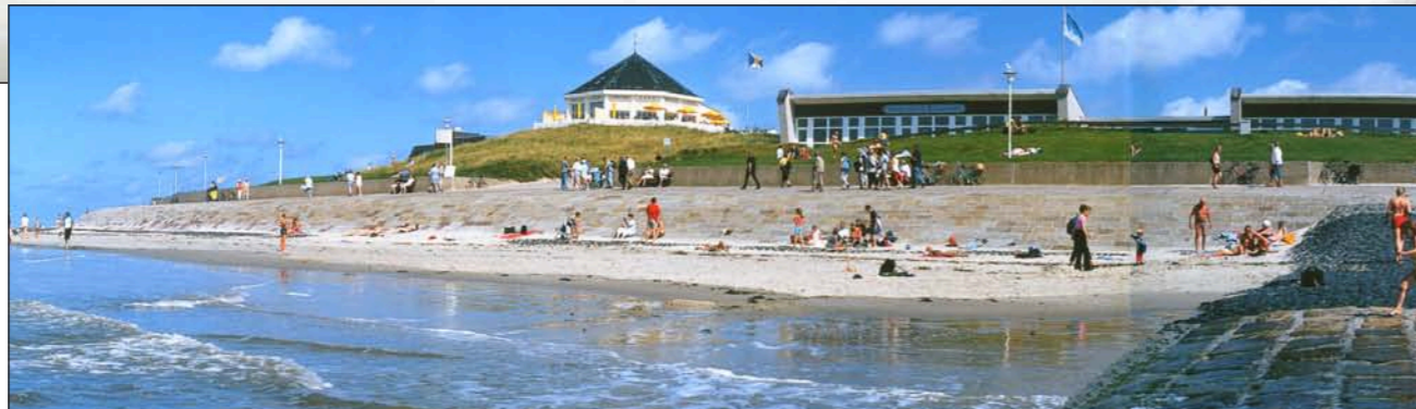
Abb. 2: Panorama mit bestehender steilen Flutmauer
