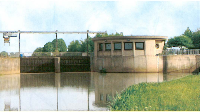
Verteilerbauwerk in der Hase zur Wasserverteilung zum Zuleiter, zur Tiefen Hase, zur Hohen Hase und zum Sögelner Mühlenbach
