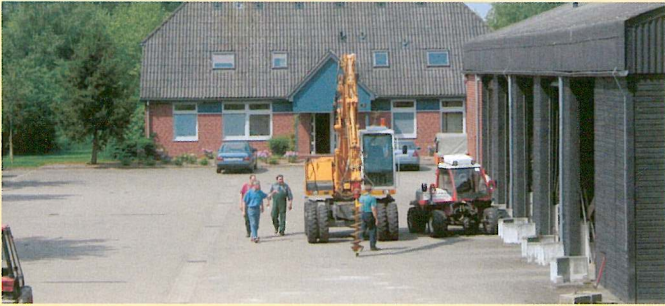
Betriebshof am Hochwasserrückhaltebecken Alfhausen-Rieste mit Steuerzentrale
