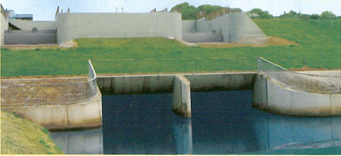
Auslaufbauwerk zur Wasserstandsregelung im Reservebecken
