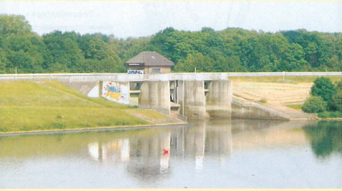
Ausgleichsbauwerk zur Wasserstandsregelung im Hauptbecken ("Alfsee")
