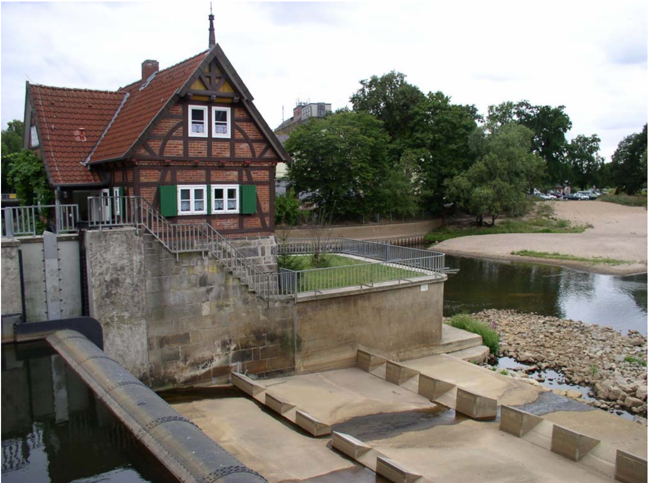
Wehr Celle an der Aller Sommer 2002, Quelle: NLWKN
