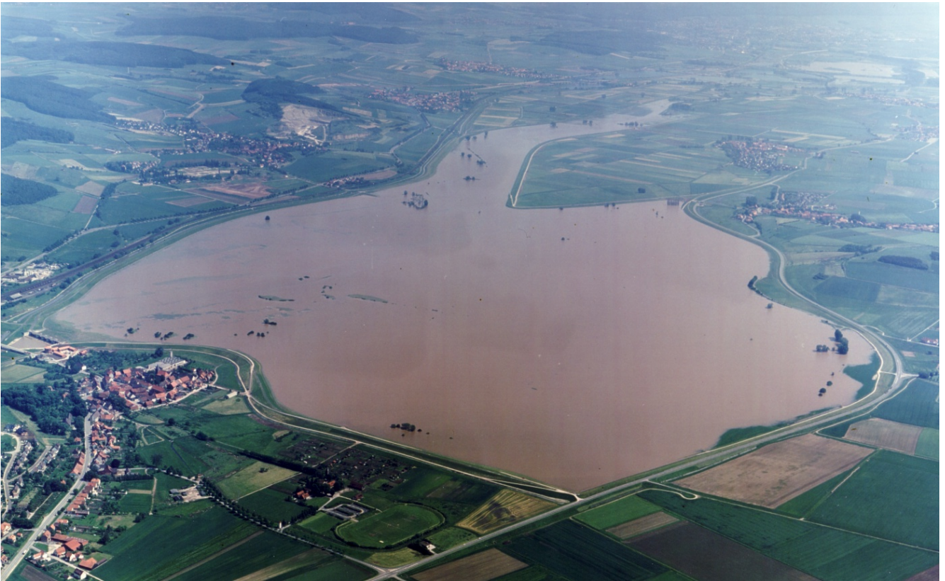
Hochwasserrückhaltebecken Salzderhelden mit gefüllten Poldern, Quelle: NLWKN
