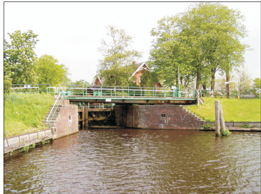
Heutige Ansicht aus dem Unterwasser
