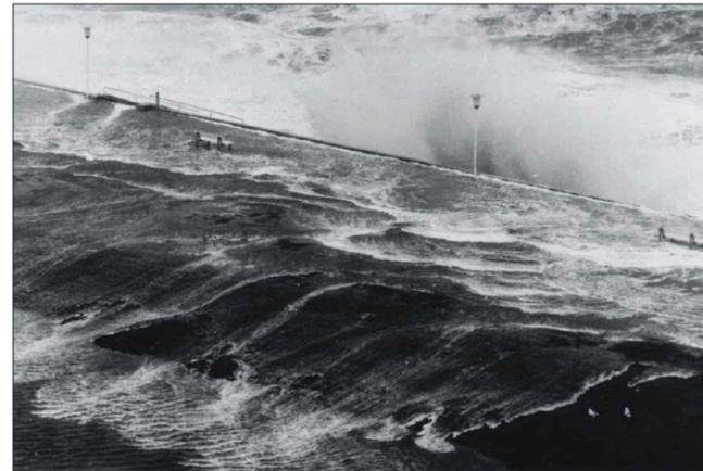
Abb. 3: Durch Wellenüberlauf am Deckwerk an der Kaiserwiese während der Sturmflut vom 03.01.1976 fließen erhebliche Mengen Wasser in die Stadt Norderney
