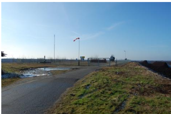
Abb. 15 Erdgasstation innerhalb des Georgsdorfer Moores (2013)
