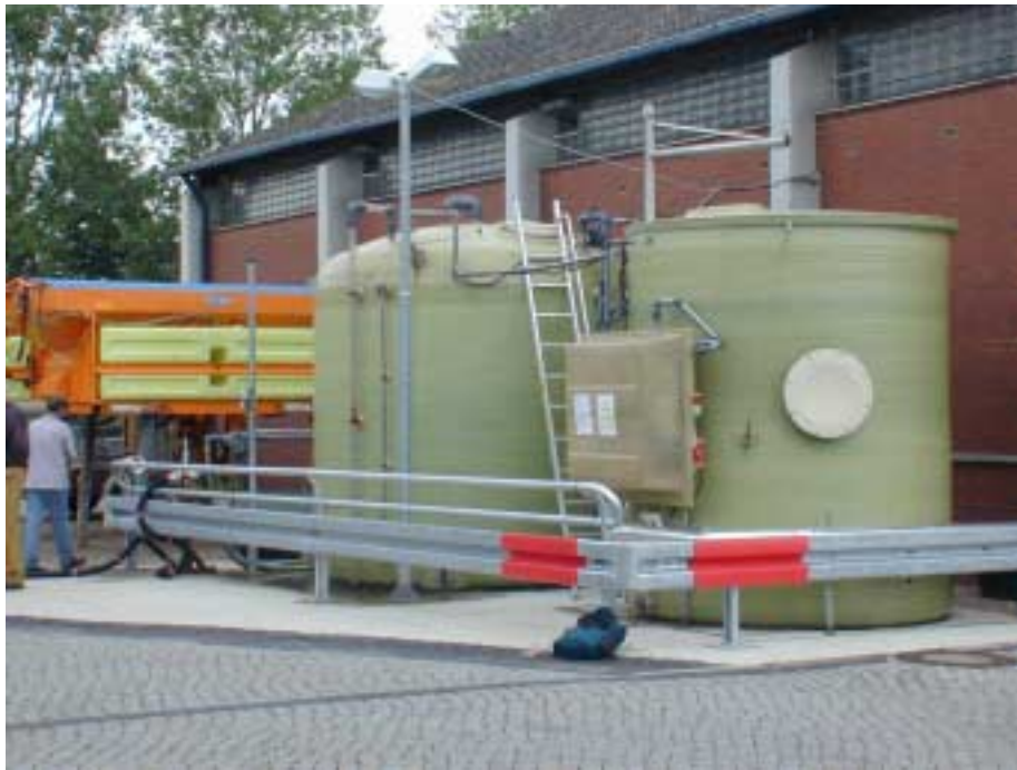
Soleherstellung und – lager mit Dichtfläche und Anfahrerschutz
