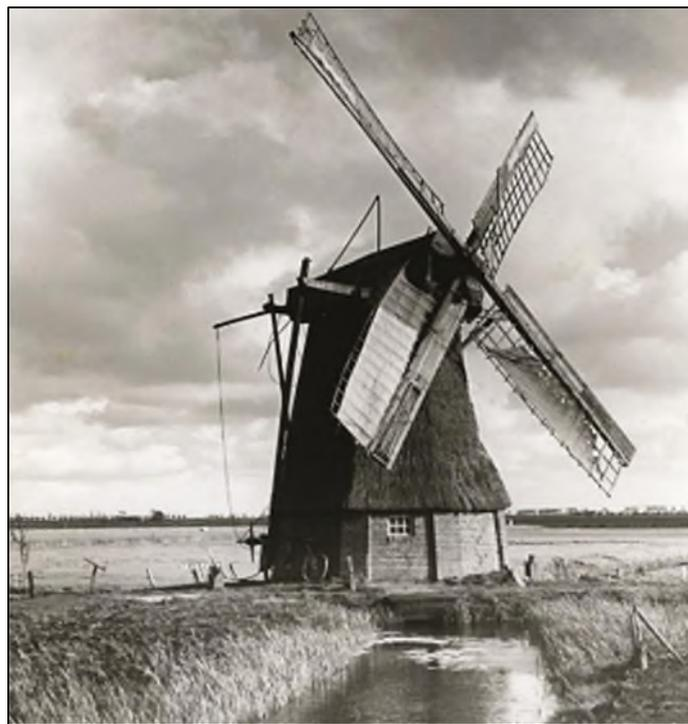
**Abbildung 35: Ehemalige Wasserschöpfmühle am Rheidermeer als Beispiel einer Entwässerung mit Windkraft (Foto: Broschüre des 1.EVE).**
