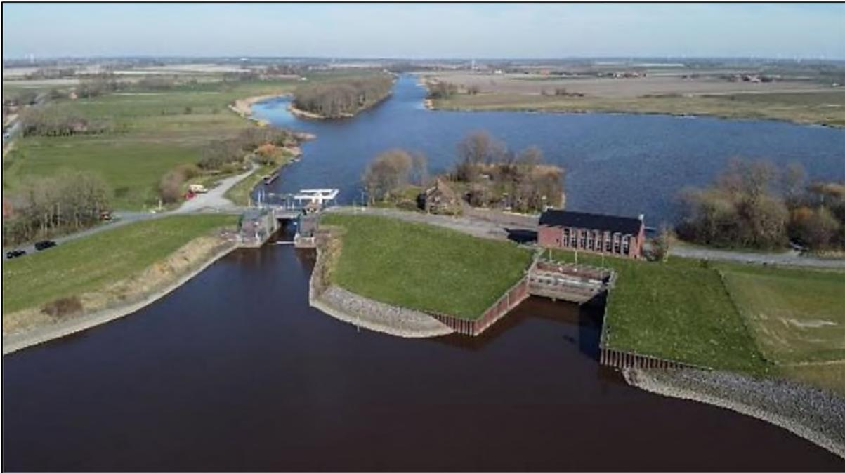
**Abbildung 36: Altes Siel (links) und Schöpfwerk (rechts) des Leybuchtseils als Beispiel einer kombinierten Entwässerung v. Siel und Schöpfwerk (Quelle: Theilis Videos).**
