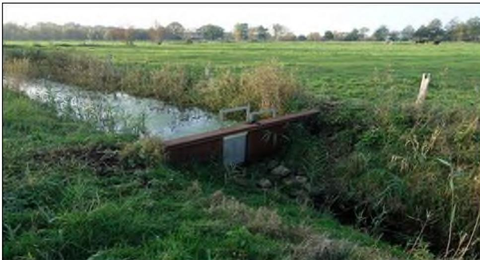
Abbildung 111: Stahlschott im Einsatz (Foto T. LINß, LK Friesland).
