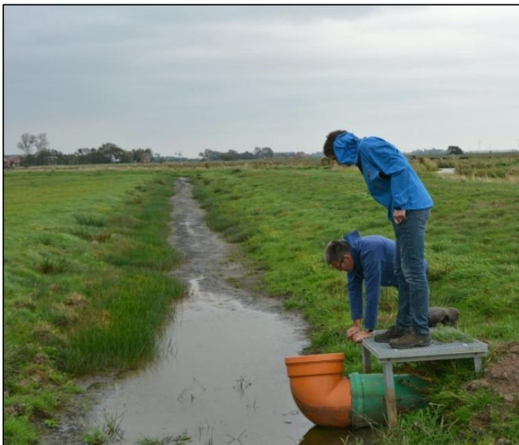
Einfache Anstauvariante mit drehbarem Rohrknie und Erdwällen (Foto: NLWKN)
