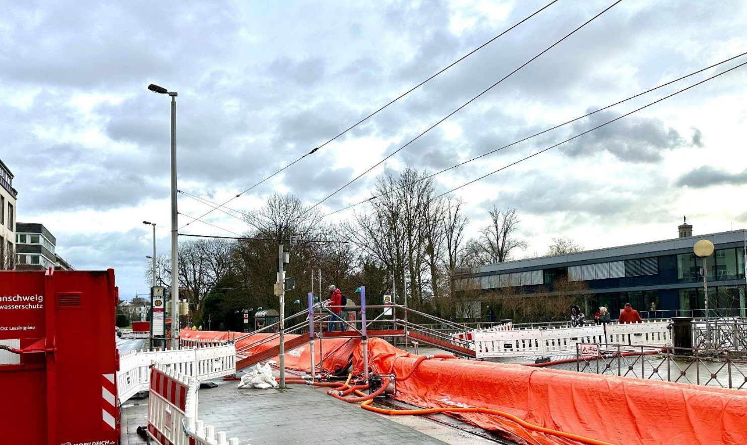
Abbildung 12: Aufbau eines mobilen Deiches in der Stadt Braunschweig (Quelle: NLWKN, Anhalt)
