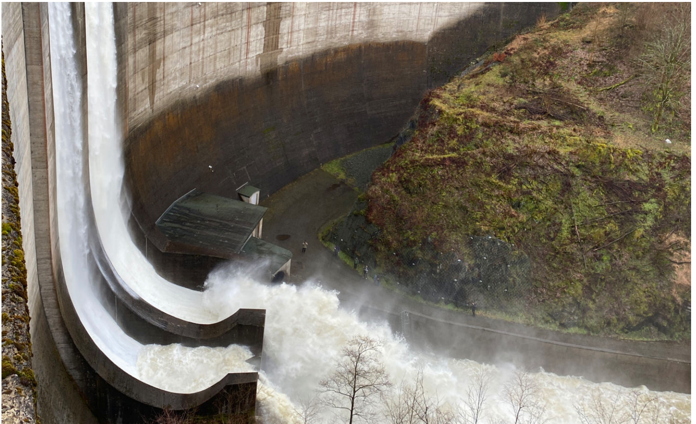
Abbildung 29: Vollstau der Okertalsperre mit Hochwasserentlastung an der Staumauer am 26.12.2023 (Quelle: Harzwasserwerke GmbH)
